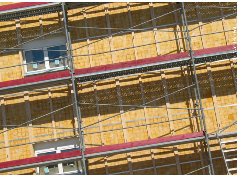
Mit hoher Wärmerückgewinnung lässt sich Dämmstärke reduzieren.
