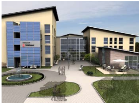
Fotos: IBN Ingenieurbüro Nordhoff
