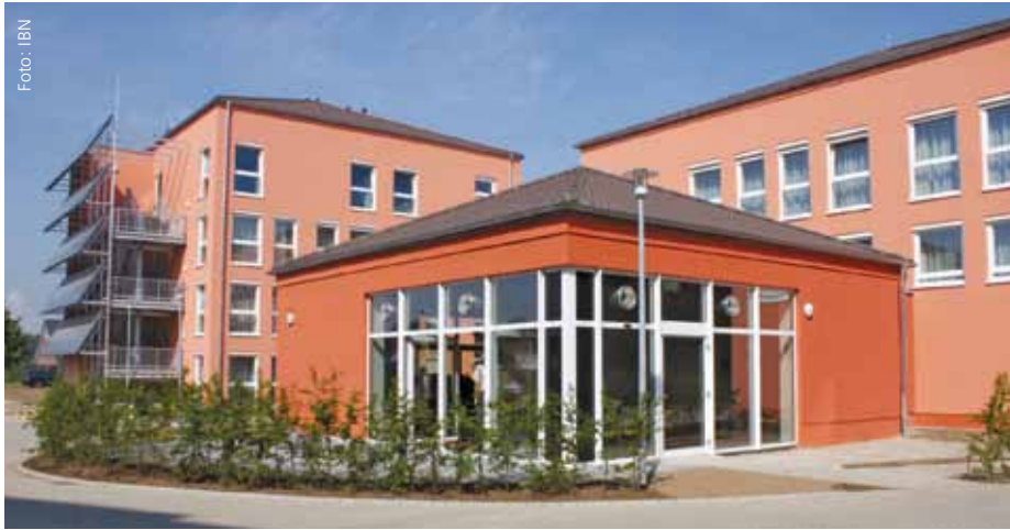
Nichtwohngebäude wie dieses Pflegeheim in Dormagen mit unterschiedlichen Funktionsbereichen erfordern viel Fachwissen und Kreativität vom Passivhausplaner.
