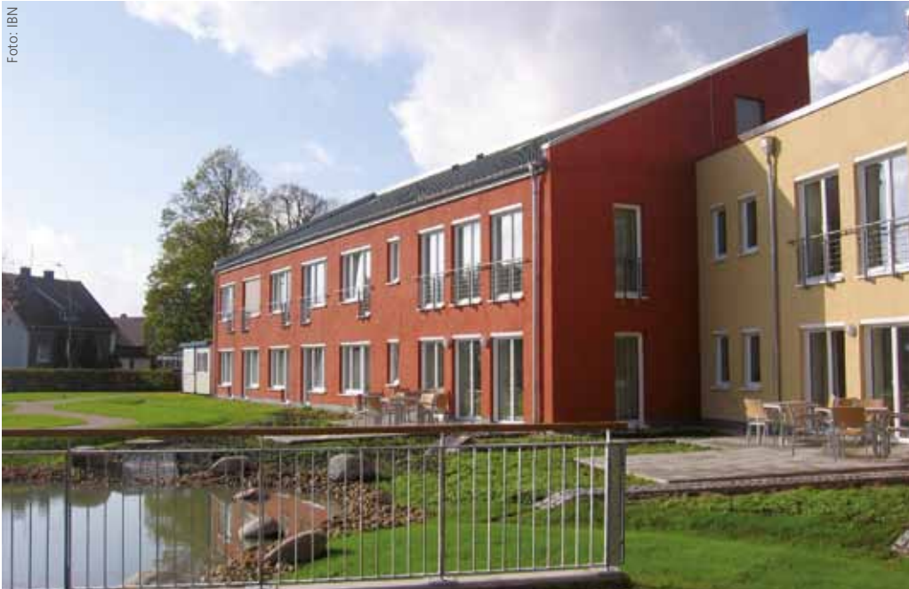
Ein Pflegeheim im Passivhausstandard. Es wird – statistisch betrachtet – nach 22,3 Jahren einem grundlegenden Umbau unterzogen.
