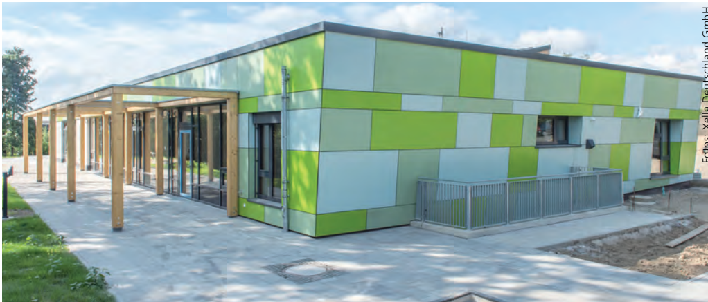
Seit Sommer 2014 werden 60 Kinder in der Passivhaus-Kita Spatzennest in Wuppertal betreut.
